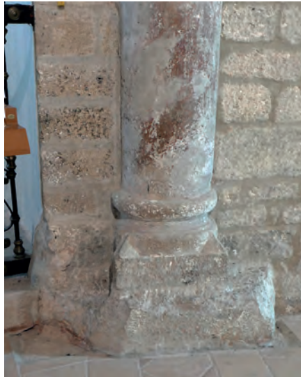
Abb. 9. Kathedrale von Acerenza: Chorumgang, Eingang der nordöstlichen Radialkapelle, Basis mit spornförmiger Eckzier und Halbsäulenvorlage als Spolie.
