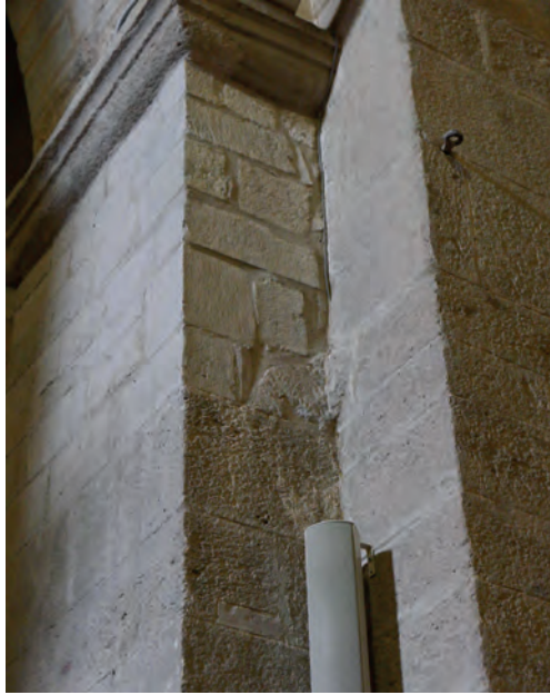
Abb. 6. Kathedrale von Acerenza: Nordwestlicher Vierungspfeiler, westl. Vorlage mit abgearbeitetem Kämpfer der romanischen Arkatur und Aufmauerungen des 15./16. Jh.
