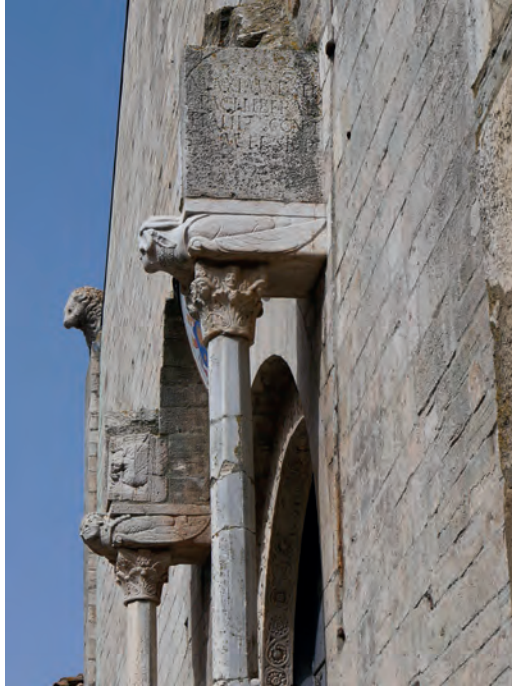
Abb. 3. Kathedrale von Acerenza: Portal mit röm. Inschriftenstein, von Süden.
