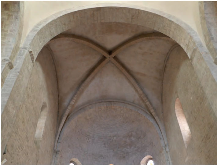
Abb. 7. Kathedrale von Acerenza: Ostseite der Vierung und Bandrippengewölbe über dem Binnenchor.
